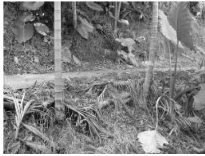
圖 9 檳榔園路側之水保工程
