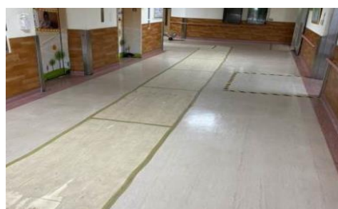
圖 25 工地動線明確標示
