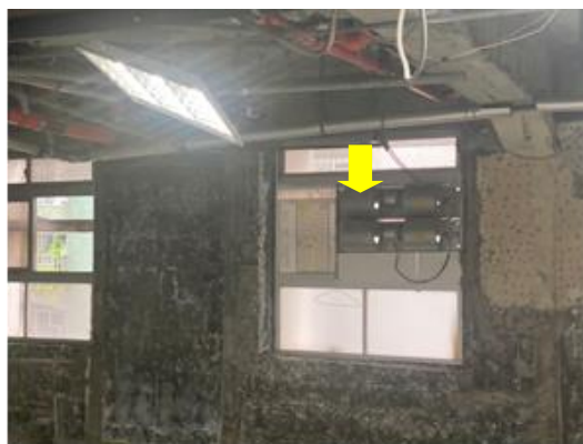
圖 20 設置抽風設備
