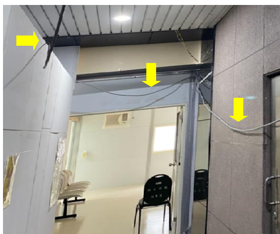
圖 15 臨時性用電未固定
