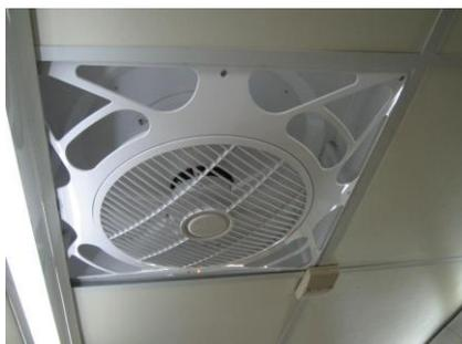
圖 11 輕鋼架專用空調循環扇
