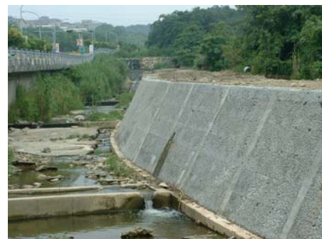
圖 3. 野溪護岸、底床之治理工程照片
