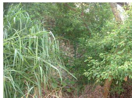
圖 4. 格框、箱籠擋土牆工程照片
