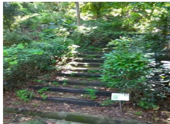
圖 11. 坡度超過 15°時，設有枕木階梯輔助
