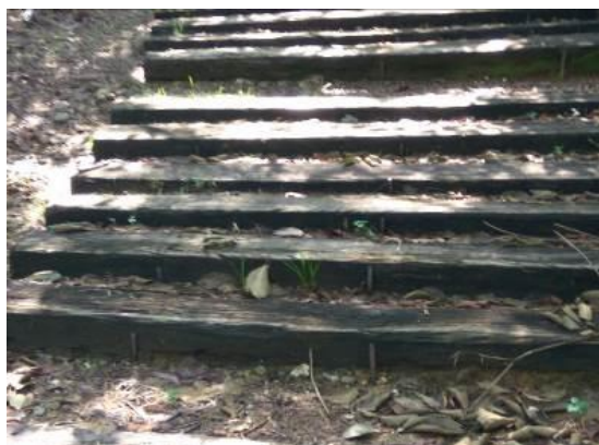
圖 6. 步道少人工設施或都市化材料，平坡為自然土質，階梯以枕木為主
