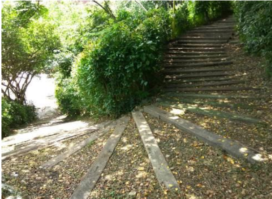
圖 15. 坡度超過 15°時，設有「Z」字型步道緩衝及枕木階梯輔助，少人工設施或都市化材料。
