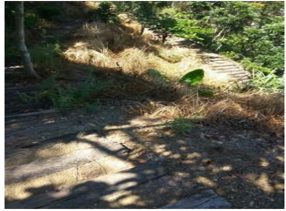
圖 14. 坡度超過 30°時，應有「Z」字型步道緩衝，但峭壁邊緣無安全欄杆。
