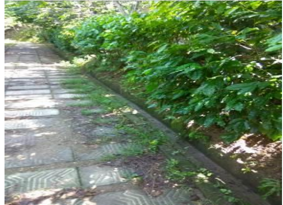
圖 10. 排水設施之設計以混凝土溝為主
