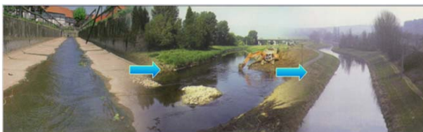
左：以單調的形式形成筆直的人工運河。中：1991年起以自然生態工法進行河川整治。右：整治後接近自然原貌。
