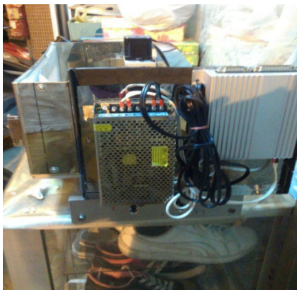
圖 6 機床側邊電機固定處
