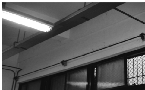
圖六 鋼管與軸承固定圖
