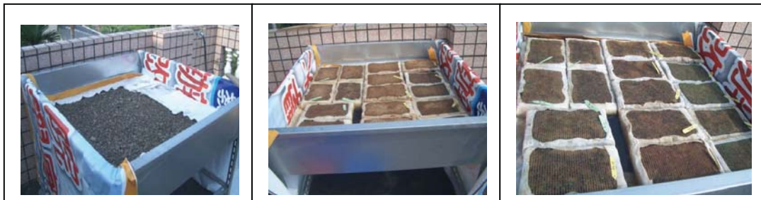
圖 10：棚架區鋪設水陶石濾材 圖 11：棚架區置放試驗植栽 1 圖 12：棚架區置放試驗植栽 2
