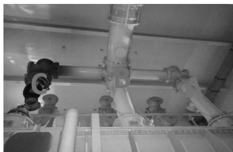
图1 C相套管直连部分烧毁示意图
