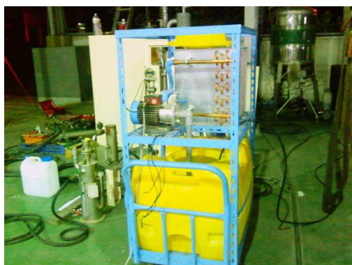
(7) EP-1000 氫氧設備及水封、冷卻器連結
